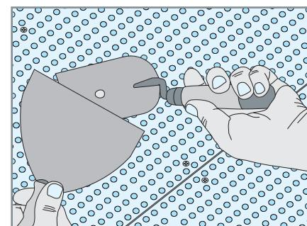
Шпаклевания стыков кромок не требуется. Шпаклевание мест установки шурупов выполняется при помощи шпаклевочной смеси КНАУФ Мульти-финиш пасты или КНАУФ Ротбанд-Пасты. Для удобства рекомендуется использовать специальный шпатель с отверстиями, соответствующего диаметра или подготовить трафарет, чтобы избежать попадания смеси в отверстия плит. После высыхания зашпаклеванные места аккуратно шлифуются, чтобы не повредить картон.
